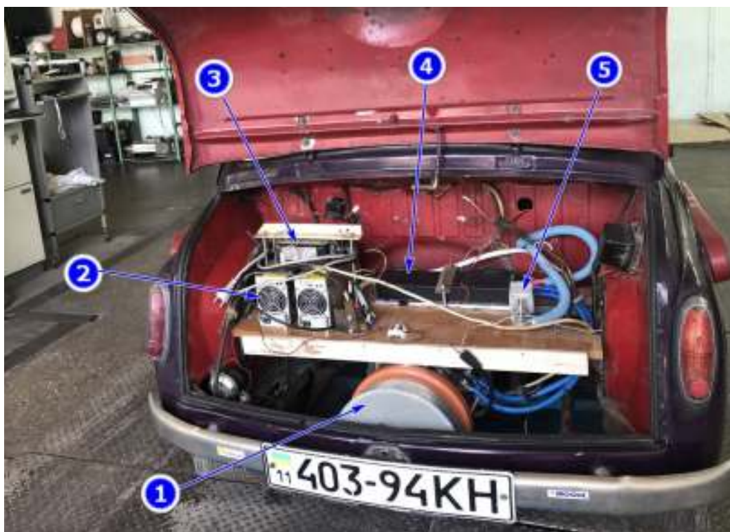
Рисунок 3 – Розміщення елементів: 1) ТЕД , 2) бортового зарядного пристрою, 3) перетворювача постійного струму, 4) блоку силових електроніки (контролера) та 5) головного запобіжника/вимикача в моторному відсіку переобладнаного автомобіля
