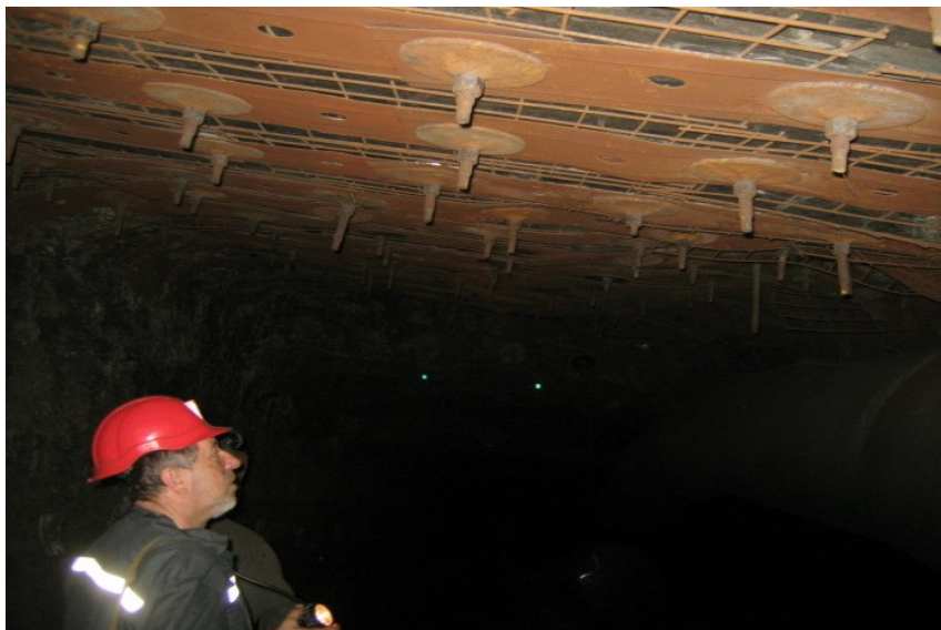
Рисунок 5 - Стан середньої частини ділянки виробки, закріпленої за українською технологією анкерними штангами номінального діаметра 25 мм із попереднім натягом 5 т
