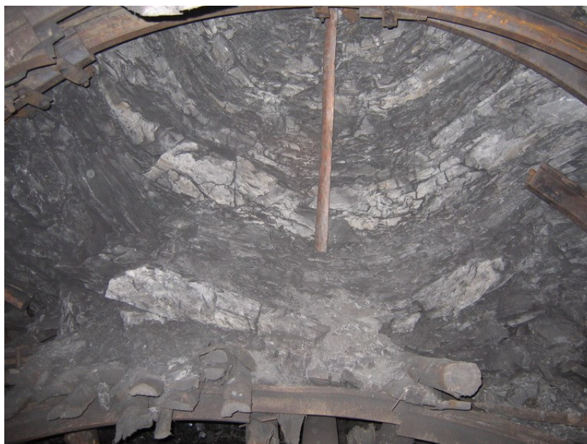
Рисунок 7 - Деформація контуру виробки конвеєрного штреку ш. Лутугінська ДП «Луганськвугілля»
