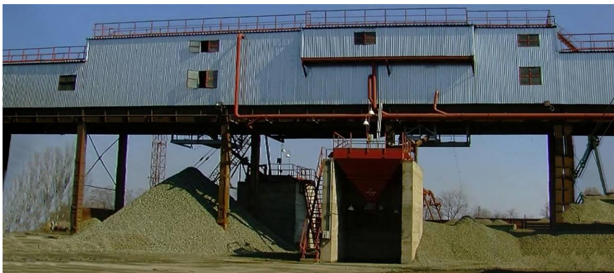
Рисунок 5 – Переработка шлаков силикомарганца на Никопольском заводе ферросплавов. МКС интегрирован в галерею дробильно-сортировочного комплекса. Украина, НЗФ
