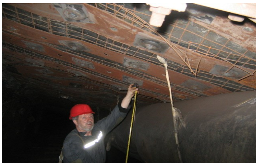
Рисунок 4 - Стан прикінцевої ділянки виробки, закріпленої за американською технологією
