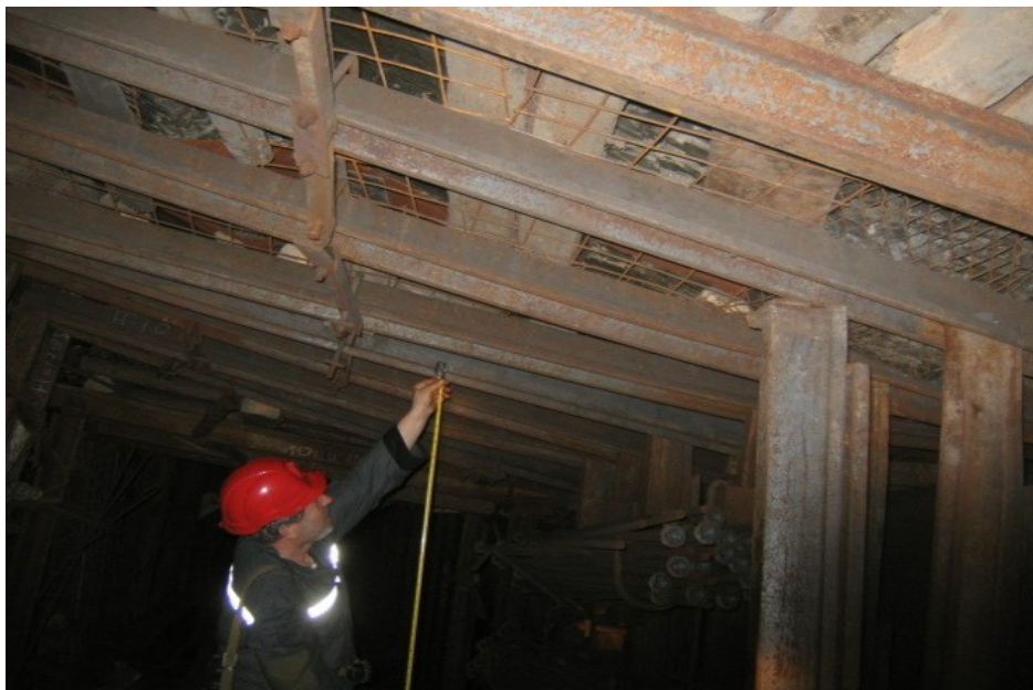
Рисунок 3 - Стан середньої частини ділянки виробки, закріпленої за американською технологією
