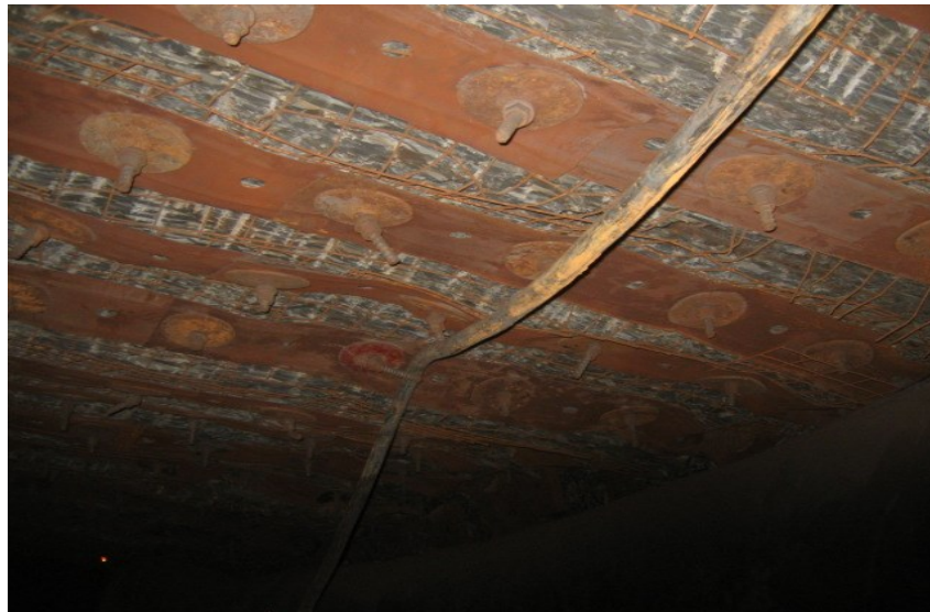
Рисунок 6 - Стан прикінцевої частини ділянки виробки, закріпленої за українською технологією анкерними штангами номінального діаметра 22 мм за наявності попереднього натягу
