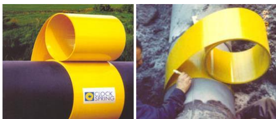
Рисунок 1 – Монтаж муфти Clock Spring
